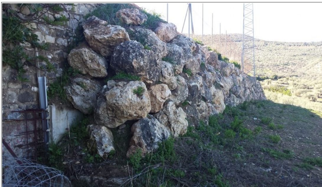
Figura 2.- Refuerzo del muro con escollera
